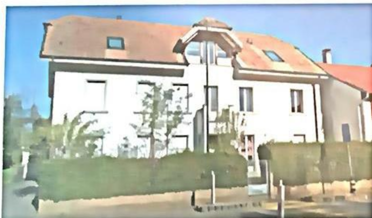
Le bâtiment actuel de la crèche-garderie Scoubidou, situé rue du Bourg, ne répond plus aux exigences en matière de sécurité.
